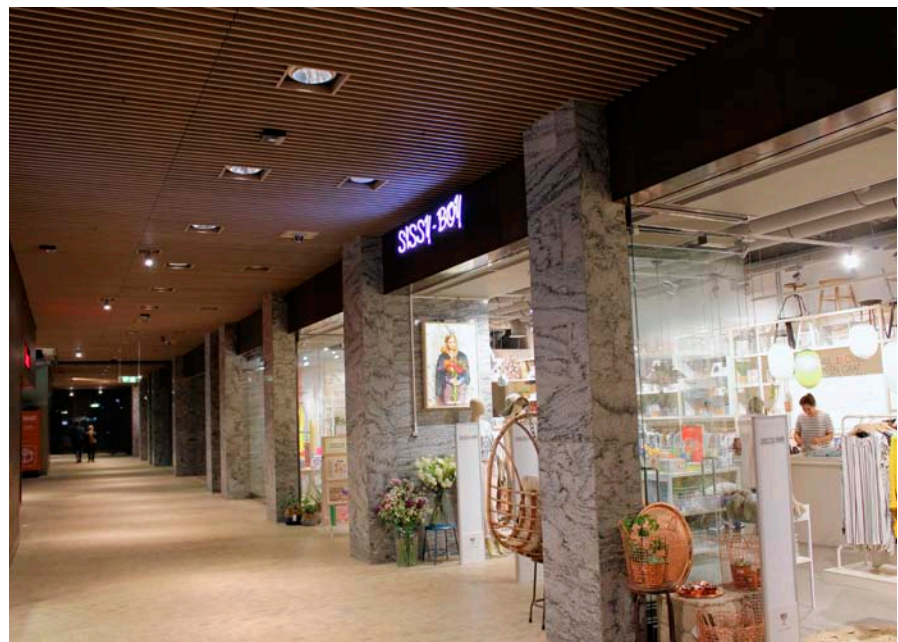
In het winkelgebied zijn Woodgrill-plafonds toegepast.
