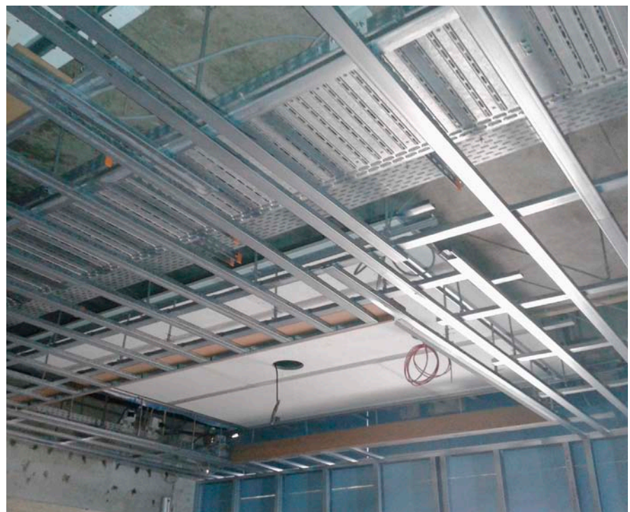
Omdat de constructie en de panelen tegen vocht bestand moeten zijn, is een corrosiewerend profiel aangebracht. (Foto: Knauf)
