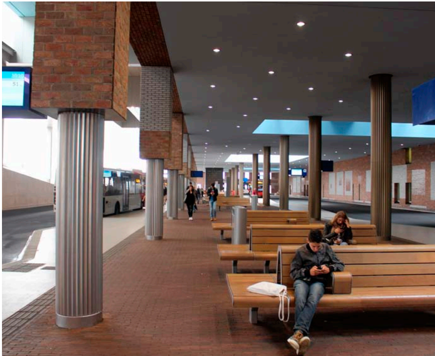
In overleg met de constructeur en Knauf/OWA zijn de buitenplafonds gedimensioneerd voor windbelasting.
