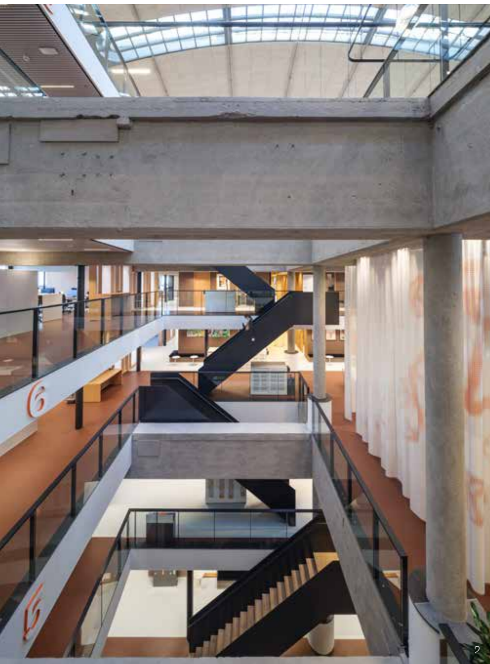
2 Om vides te creëren zijn de betonnen vloeren in het midden open gesneden.
